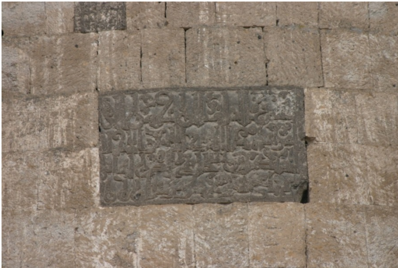
Fot. 9 : Ani Orta Kapının Batısındaki Burç İnşa Kitabesi
