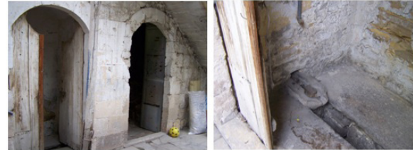
Resim 19. Zemin Kattaki Tuvalet
