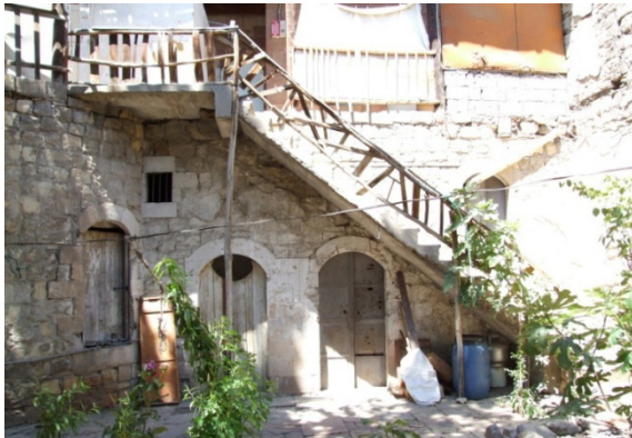
Resim 22. Birinci Kata Çıkış İçin Sonradan Eklenen Beton Merdiven
