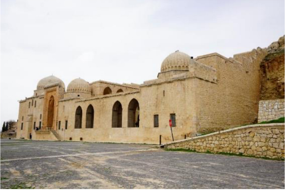
Fotoğraf 30: Mardin Kasımiye Medresesi Güney Cephe ve Doğu Cephe Duvarı
