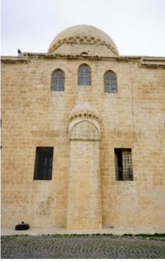
Fotoğraf 5: Kasımiye Medresesi Güney Cephede Yer Alan Payanda Çizim 9: Kasımiye Medresesi Güney Cephede Yer Alan Payandanın Çizimi Kaynak: VGMA
