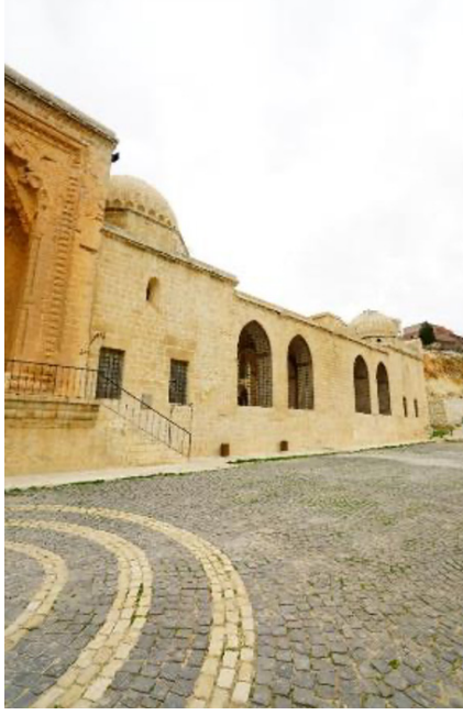
Fotoğraf 7: Kasımiye Medresesi'nin Güney Cephesinin Doğu Kısmı
