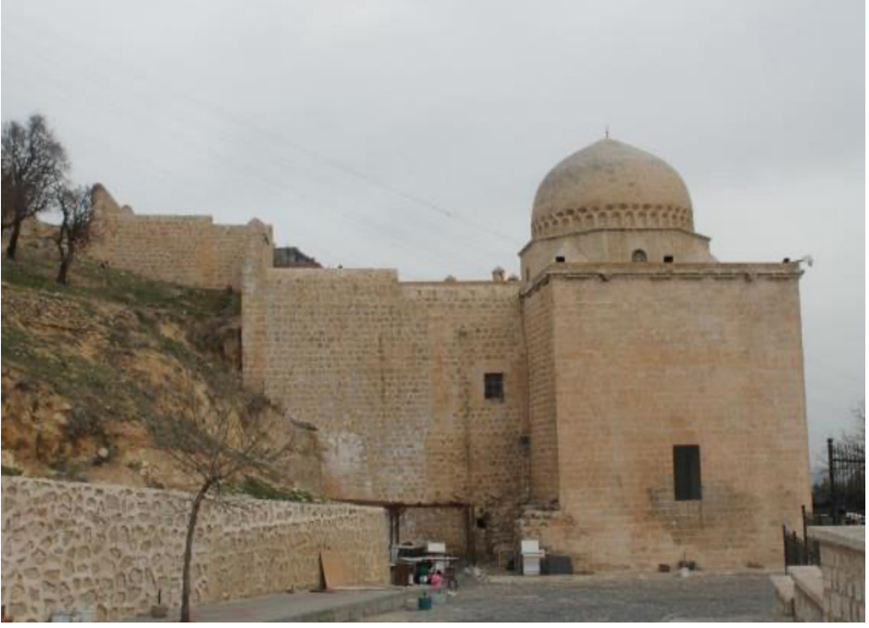
Fotoğraf 8: Kasımiye Medresesi, Batı Cephe Görünüşü
