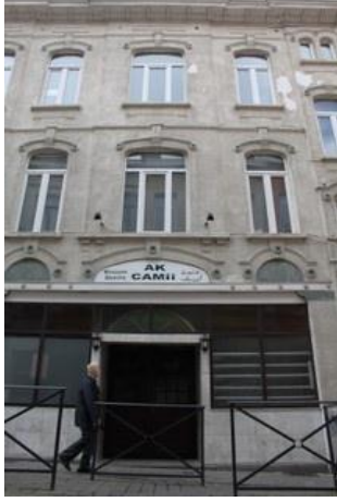
Fotoğraf 4: Brüksel Ak Camii, cephe. Önde metal konstrüksiyon.
