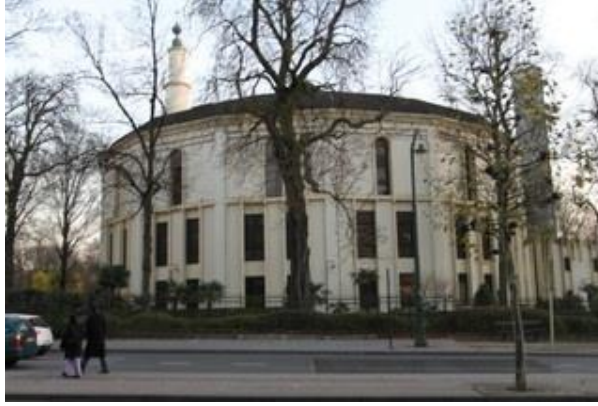
Fotoğraf 1: Grande Mosquée Bruxelles, cephe.
