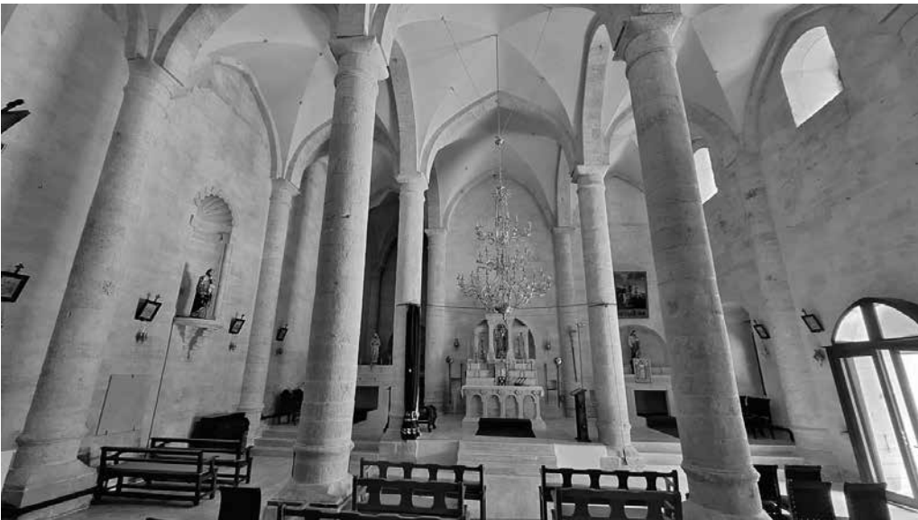
Res 8: Kilise içinden apsis ve sunağın doğu cephesinin görünümü (Murat Çağlayan, 2024).
