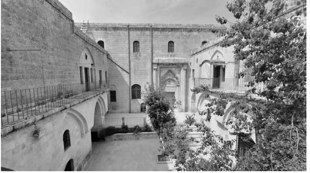
Res. 2: Avludan kilisenin güney cephesi görünümü (Murat Çağlayan, 2024).
