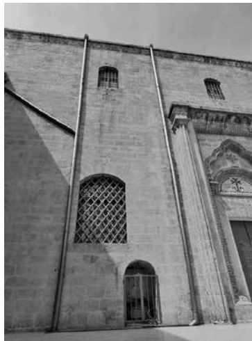
Res. 12: Solda çörttenlerden iniş boruları ile kuyuya yağ- mur suyunu biriktiren kuyu sistemi, sağda ise avludaki sıkım (maasara) taşı (Murat Çağlayan, 2024).
