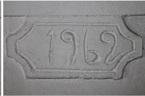
c) ocak üzerindeki konutun yapım tarihi
