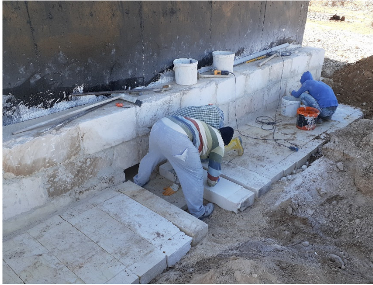
Şekil 3. 28 Havuz tahliye kanalı ve galeri kanalı döşemesi
