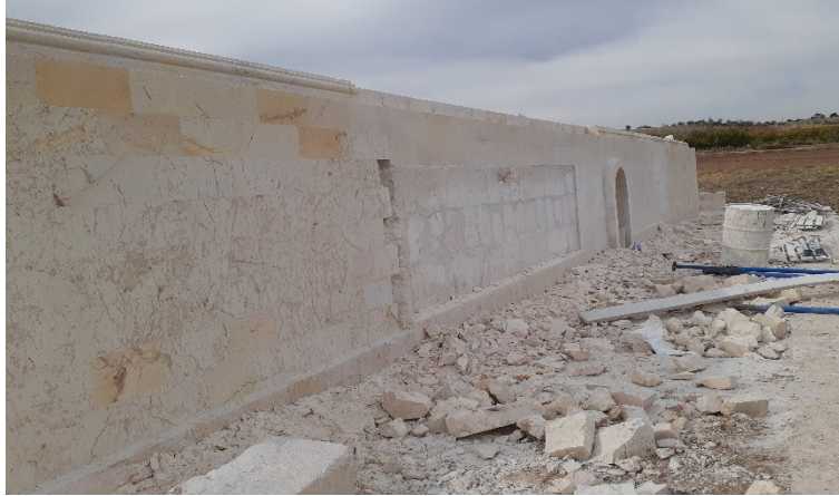
Şekil 3. 25 Havuz temeli doğu cephe görünüşü
