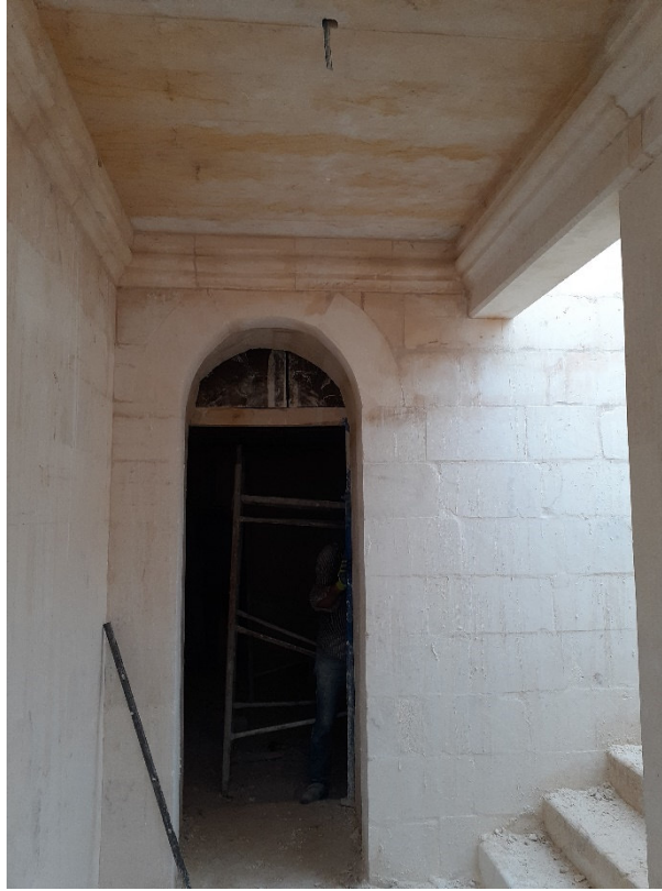
Şekil 3. 15 Merdiven sahanlık döşeme altı
