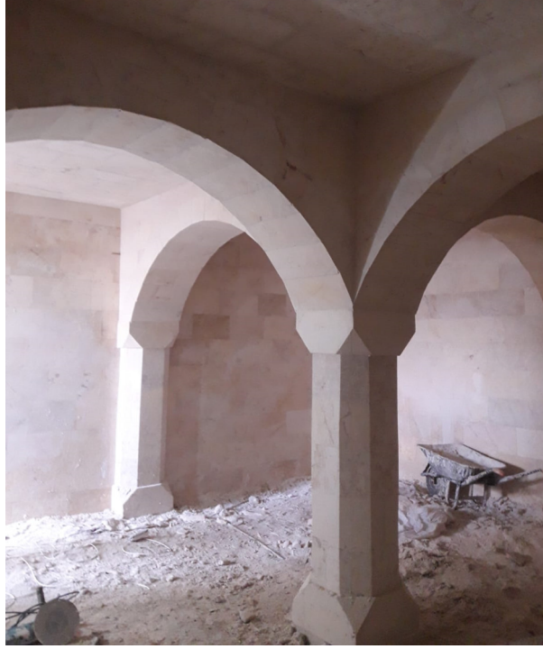
Şekil 3. 14 Riyad altı orta kolon ve kemerler
