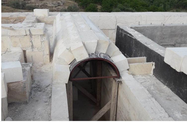
Şekil 3. 29 Havuz etrafı galeri kanalı basık tonoz
