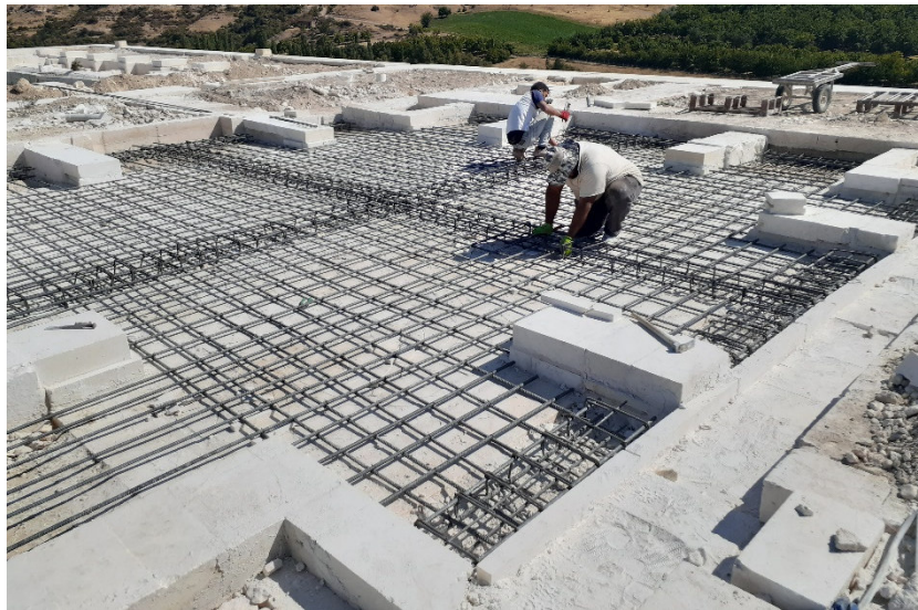
Şekil 3. 13 Riyad bodrum kesme taş üzeri donatı bağlanırken
