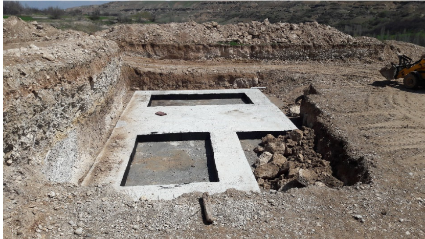
Şekil 3. 2 Bodrum temel hatılı
