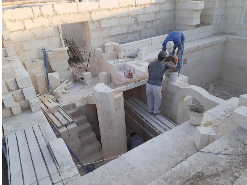
Şekil 3. 17 Merdiven kollarını taşıyan sekizgen kolonlar
