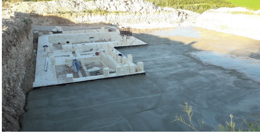
Şekil 3. 8 Temel hatılları altı grobeton uygulaması ve taş duvar yalıtımı
