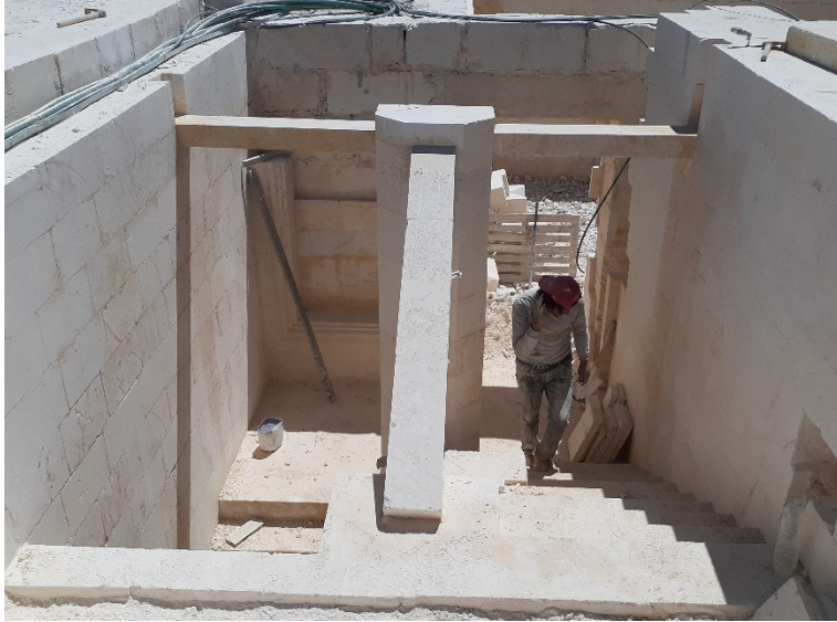
Şekil 3. 20 Merdiven kollarını taşıyan taş kirişler
