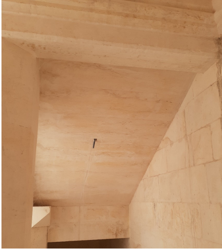
Şekil 3. 21 Merdiven altı eğik döşeme alttan
