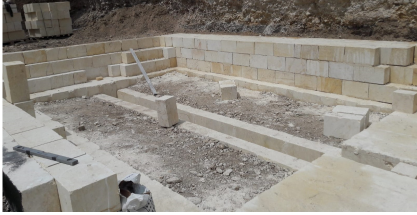
Şekil 3. 9 Kesme yontu taşların bağlantılı olarak örülmesi
