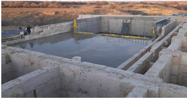
Şekil 3. 26 Havuz birinci kademenin radye temeli
