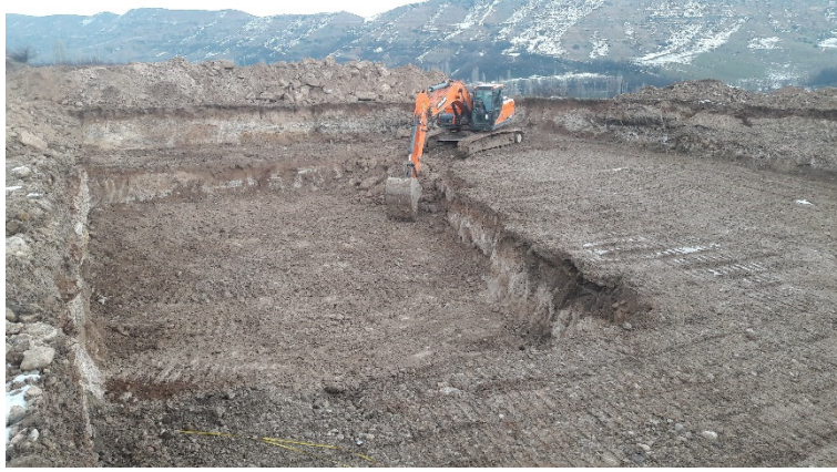
Şekil 3. 1 Binanın temelini açılması
