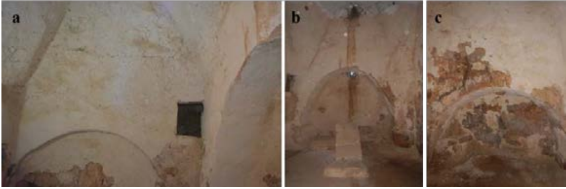
Şekil 18. (a) Şapelde bulunan boşluk, (b) şapel doğu duvarı, (c) şapel güney duvarı.
