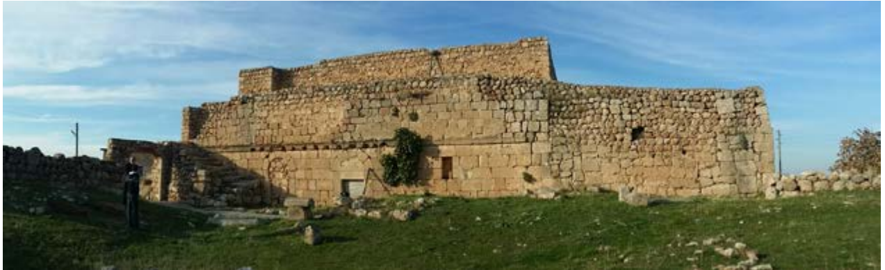
Şekil 16. Güney cephesi genel görünüş
