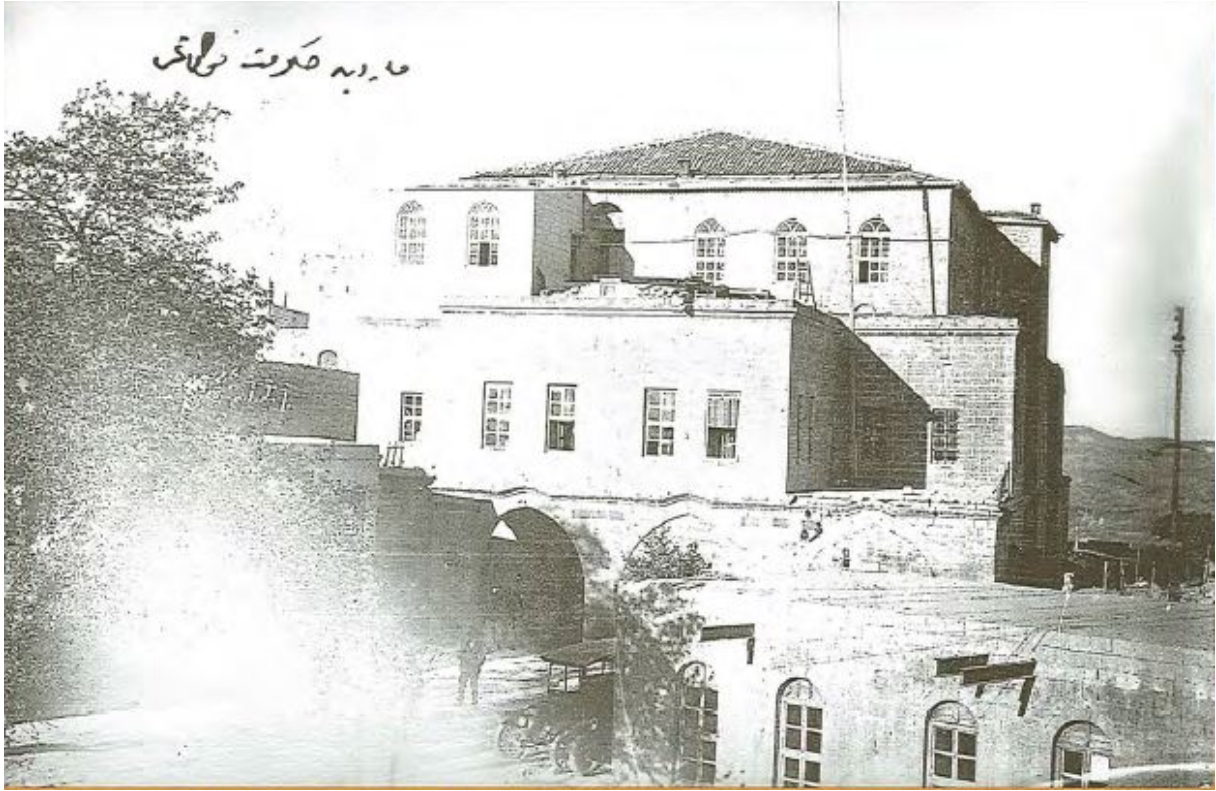
Fotoğraf 50 Eski Hükümet Konağı, 1915
