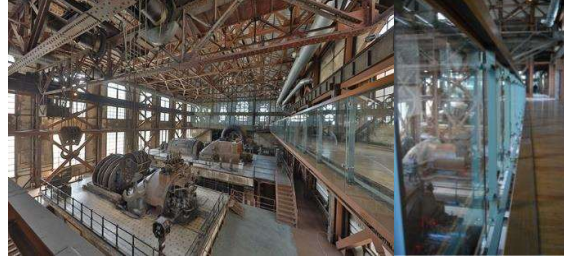
Şekil 6. Silahtarağa Elektrik Santrali'nde cam kullanımı (Kaşlı, 2009)
