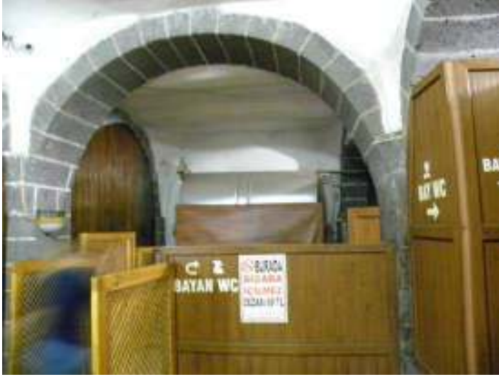
Resim 13: Yapının Kuzaybatı Köşesinde Bodrum Katta Bulunan Islak Mekanlar
