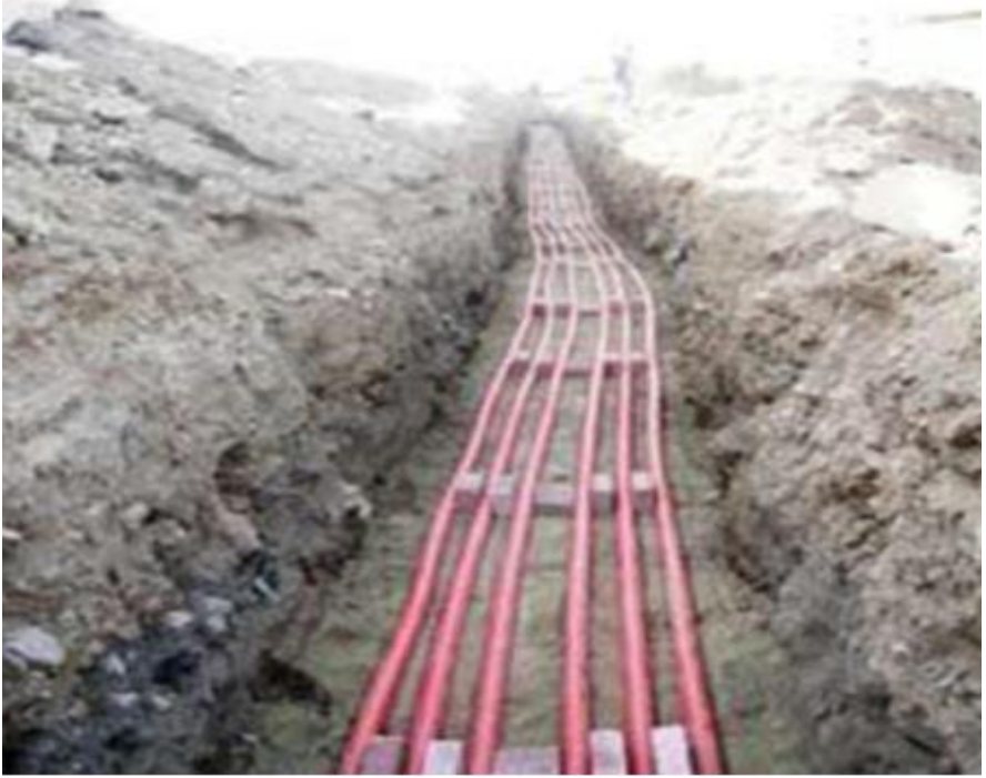
Şekil 4. Yer Altı Kablolarının Döşenmesi
