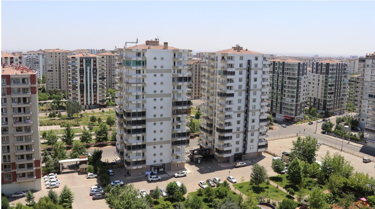
Fotoğraf 2: Diyarbakırda yeni yapılaşmanın yoğun olduğu Kayapınar ilçesi 75.metrelik yol (2020)
