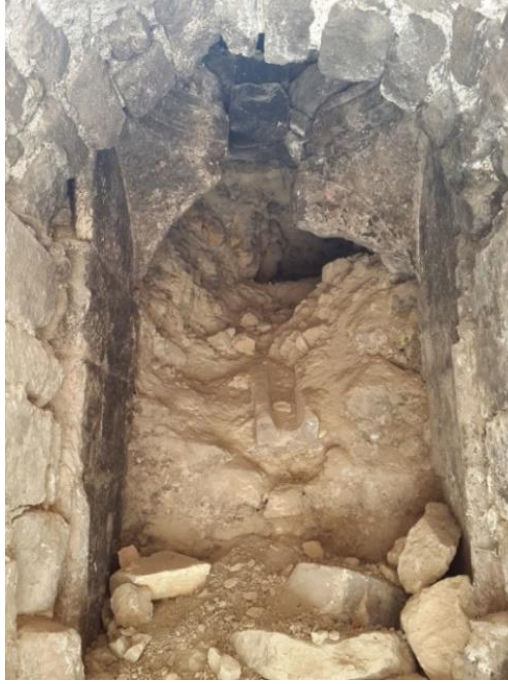
Şekil 5. Medresenin kuzey istinat duvarı içinde kalan eski su kanalı (Murat Çağlayan Arşivi)
