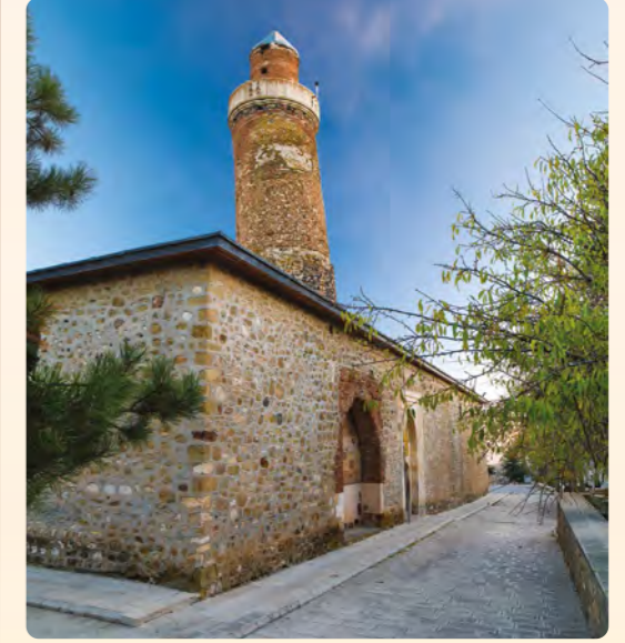
Fotoğraf 6: Artuk Oğlu Sökmen Oğlu Davud Oğlu Sultan Karaarslan Tarafından 1157 Yılında İnşa Edilen Harput Ulu Cami
