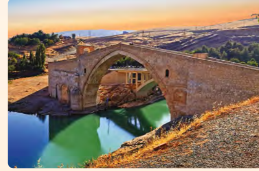
Fotoğraf 1: 1147 Tarihli İnşa Kitabesine Göre, Timurtaş Oğlu İlgazi Oğlu Artuk Tarafından İnşa Edilen Diyarbakır Malabadi Köprüsü
