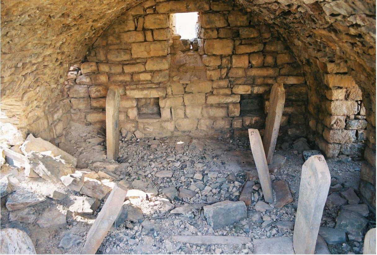
Fot. 2: Derzin Kalesi I. Türbe İç Mekandan Görünüş (A. Boran Arşivinden)
